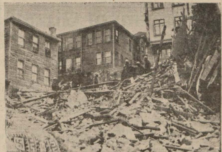
Topuzcu sokağında apartman çöktükten sonraki hal
